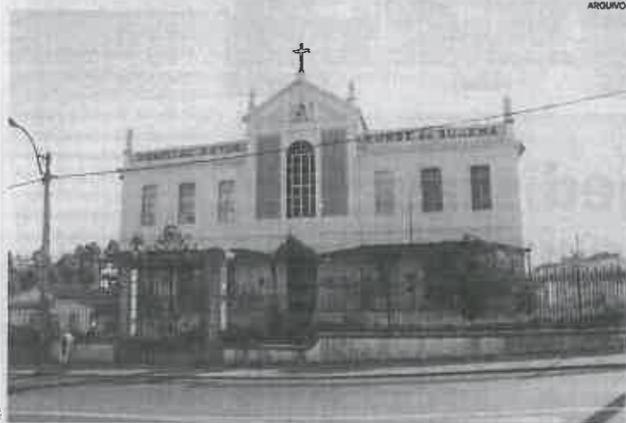
As urgências do Hospital de Águeda vão entrar em obras
